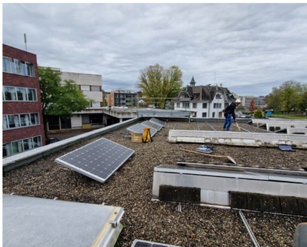
Titelseite und oben: Arbeiten an der PV-Anlage in Allschwil. Die vier links liegenden Module mussten aufgrund neuer Dachaufbauten umplatziert werden.
