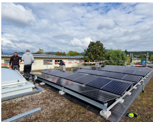
Montage der neuen PV-Anlage Kettenackerweg in Reihen.
