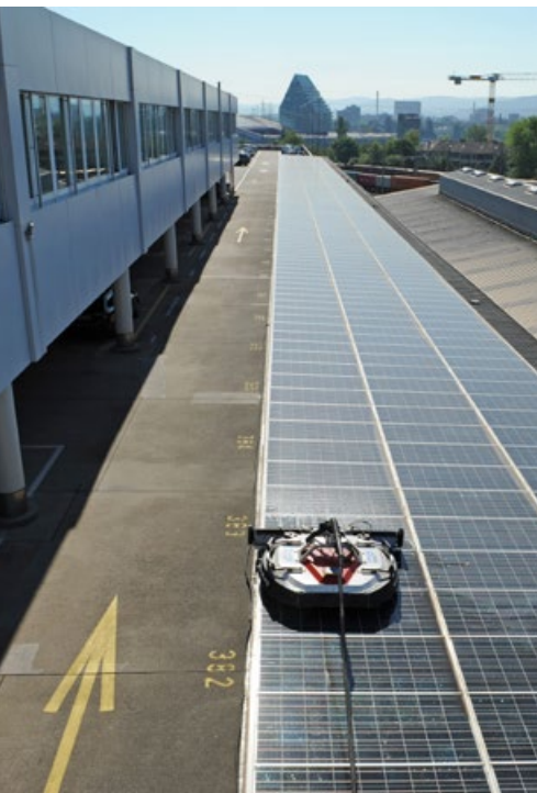
Abb. 6: Reinigung der PV-Anlage UAG mit einem Putzroboter Ende Mai.
