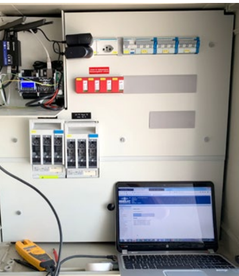
Abb. 8: PV-Anlage Schäferweg: Einbau eines neuen Datenloggers.
