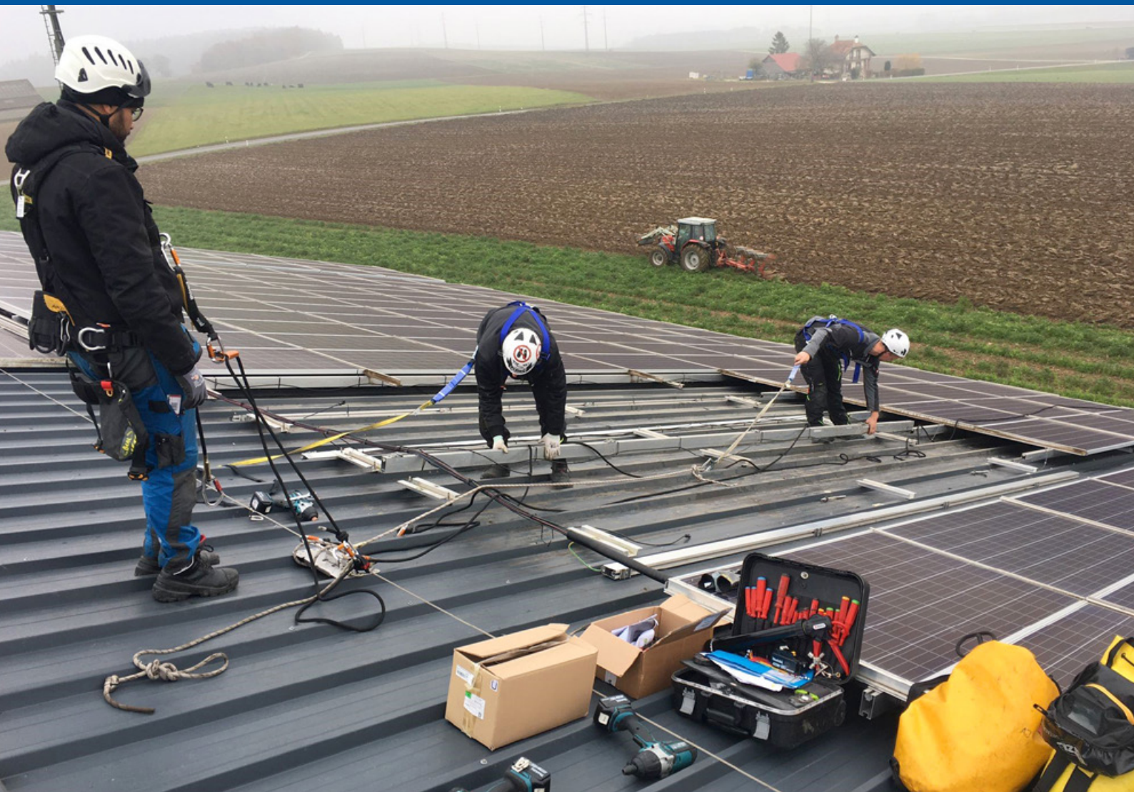
PV-Anlage Turin in Valeyres-sous-Rances (VD): Abdichtungsarbeiten
