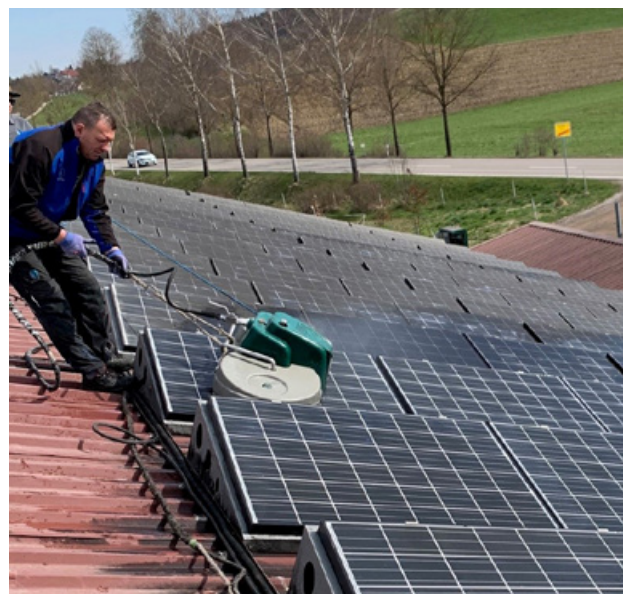
Reinigungsarbeiten auf der PV-Anlage Fischach (D)
