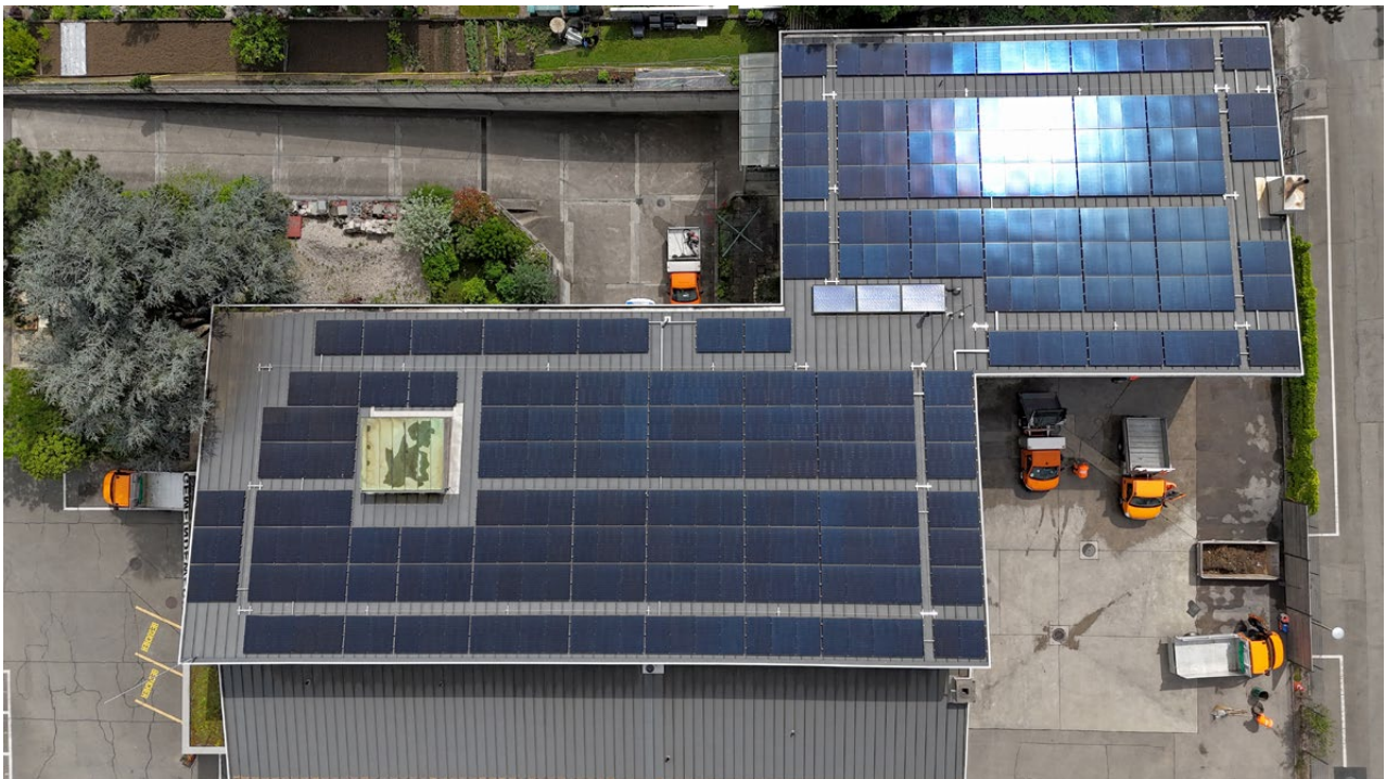
Die geplante PV-Anlage auf dem Neubau Werkhof in Laufen wird ähnlich gross wie diejenige auf dem Werkhof in MuttENZ (Bild) mit 140 kWp. In Laufen ist ein Batteriespeicher geplant, in MuttENZ wird der Einsatz zurzeit geprüft. Drohnenaufnahme: Yannick Schütz
